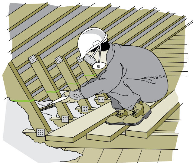
Figure 5-14 Pose de l'isolant en vrac
