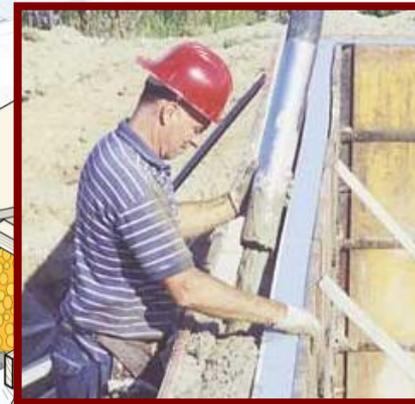
95 mm (3 ¾ po) minimum polystyrène expansé inséré dans le coffrage
